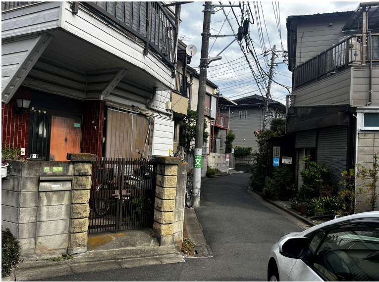
位置指定道路入口から 東方向
